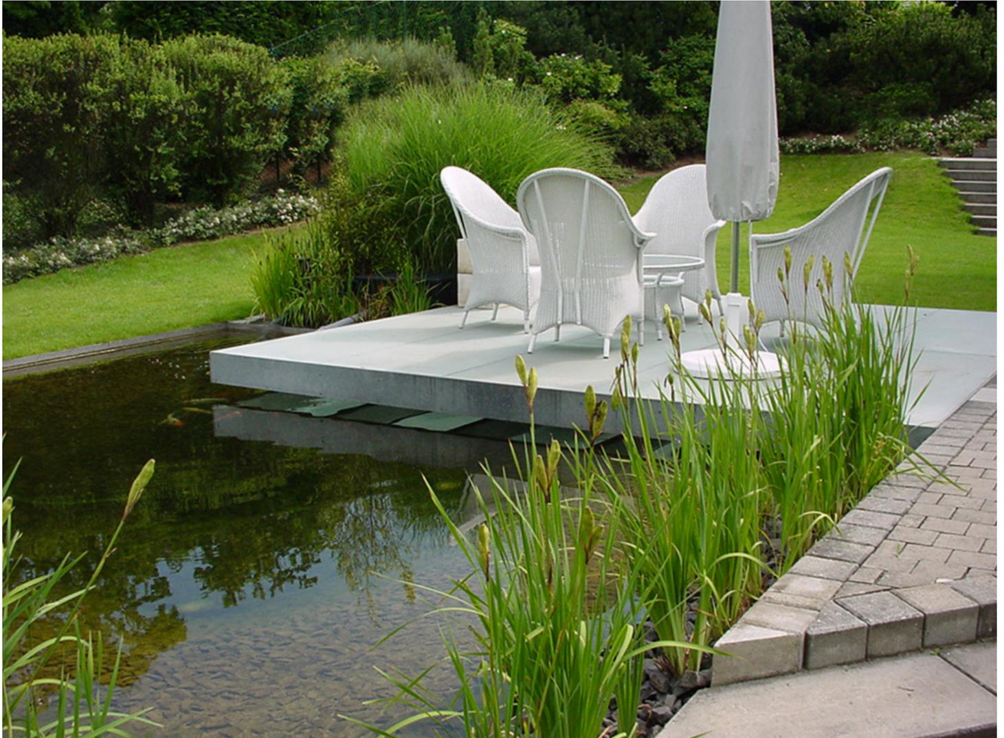
Aus Gründen der Alterung und Ästhetik eines Sitzplatzes auf und über einer Wasserfläche wurde nicht wie sonst üblich Holz, sondern Glas als Belag gewählt. Die Glaselemente sind in einen Edelstahlrahmen gelegt und absolut rutschfest. Das Glas vermittelt ein Gefühl des Schwebens und der Leichtigkeit.
